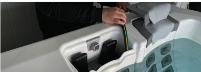
**Étape 3 :** Remplissez le spa jusqu'à l'indicateur de niveau d'eau ou jusqu'à la mi-hauteur de la grille d'entrée du filtre et passez à la procédure de démarrage.
