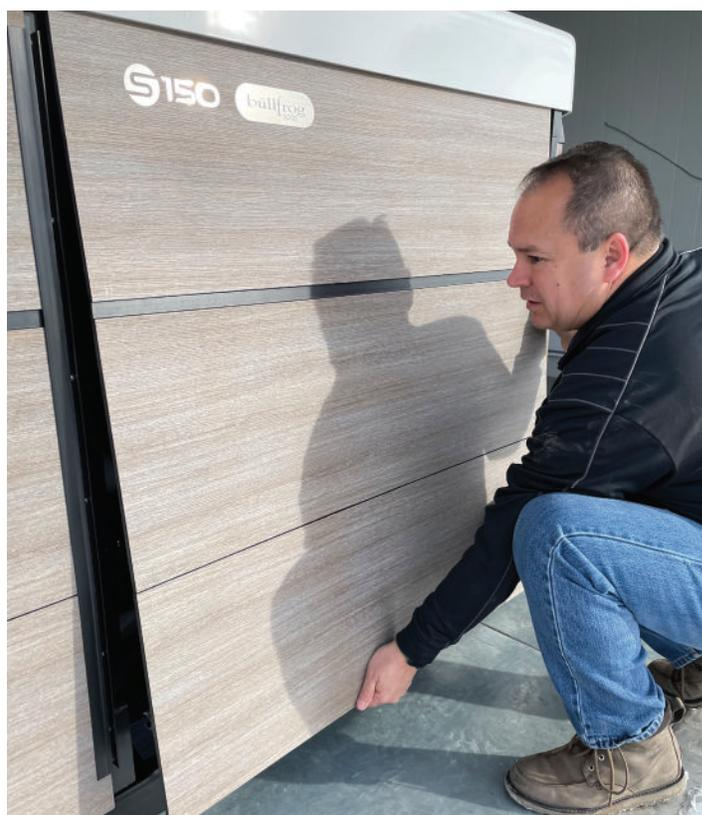
**Étape 2 :** Remplacez les bandes de garniture en enclenchant soigneusement chaque bande dans le canal de garniture.
