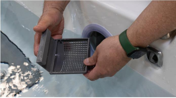
**Étape 5 :** Remplacez les paniers à leur emplacement original à l'intérieur de la prise d'air du filtre et remplacez la grille en l'enclenchant en place.
