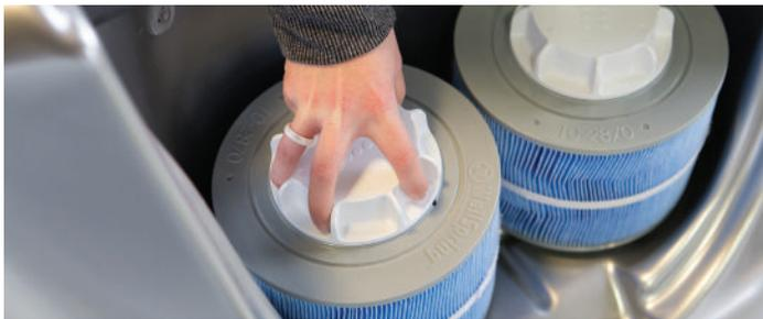
**Étape 3 :** Retirez la (les) cartouche(s) plissée(s) en tournant le(s) bouchon(s) du noyau du filtre dans le sens inverse des aiguilles d'une montre, puis en faisant glisser la (les) cartouche(s) vers le haut du noyau du filtre.
