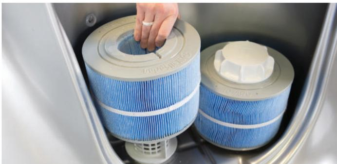
**Étape 4 :** Nettoyer la ou les cartouches à l'aide d'un boyau d'arrosage muni d'une buse ou d'un autre dispositif à haute pression. Travaillez d'abord de l'intérieur, de haut en bas sur chaque pli, puis de l'extérieur, de haut en bas sur chaque pli.
