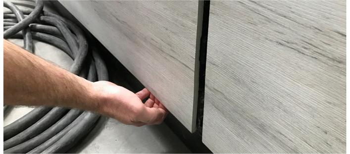
**Étape 3 :** Débranchement électrique : Assurez-vous de débrancher les éclairages ou tout autre câblage électrique monté sur la porte avant de la retirer complètement.
