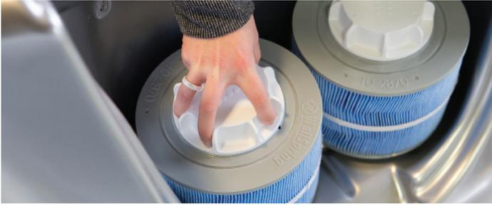
**Étape 3 :** Retirer la ou les cartouches plissées en tournant le ou les couvercles du noyau filtrant dans le sens inverse des aiguilles d'une montre, puis en faisant glisser la ou les cartouches vers le haut à partir du noyau filtrant.
